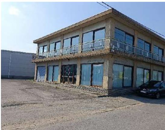
Foto 1: Zicht op bestaande kantoorgebouw.
