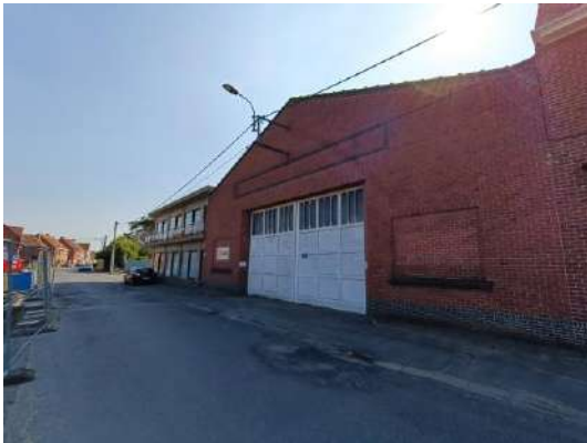
Foto 23: Te behouden kantoor en loods.
