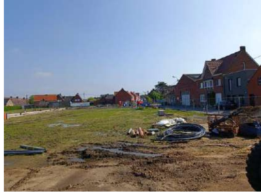
Foto 22: Aanleg nieuwe verkaveling tov site Bruynooghe in de Snejpestraat.
