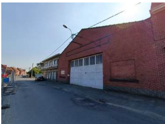
Foto 23: Te behouden kantoor en loods.
