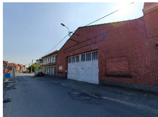
Figuur 31: Voorgevel behouden loods
