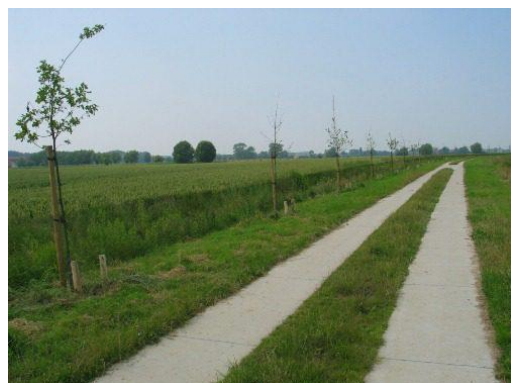
Foto 40: Illustratie van tweesporenbeton (locatie onbekend)
