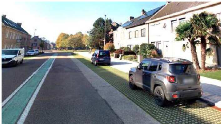
Figuur 92: Waterdoorlatende parkeerstrook Eupenlaan, Temse
