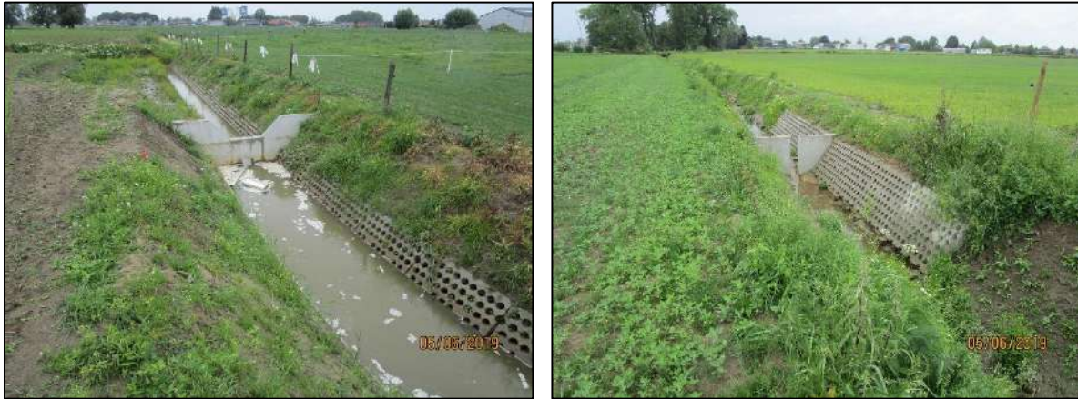
Figuur 98: Voorbeeld van een buffergracht in Ingelmunster
