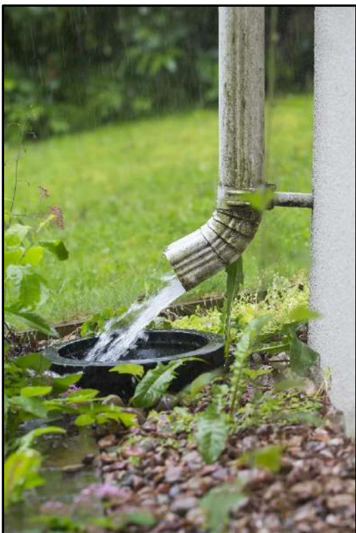
Figuur 75: Afkoppelen dakafvoer van het afvoerstelsel
