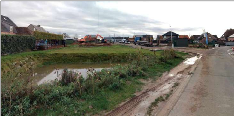
Figuur 82: Bufferbekken bij verkaveling in aanleg Pierine Coopmansstraat (Sacramentstraat)
