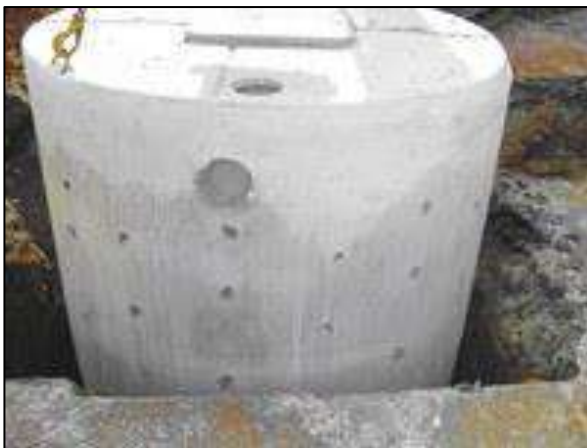
Figuur 95: Infiltratieput (VMM, Infiltratie, 2020)
