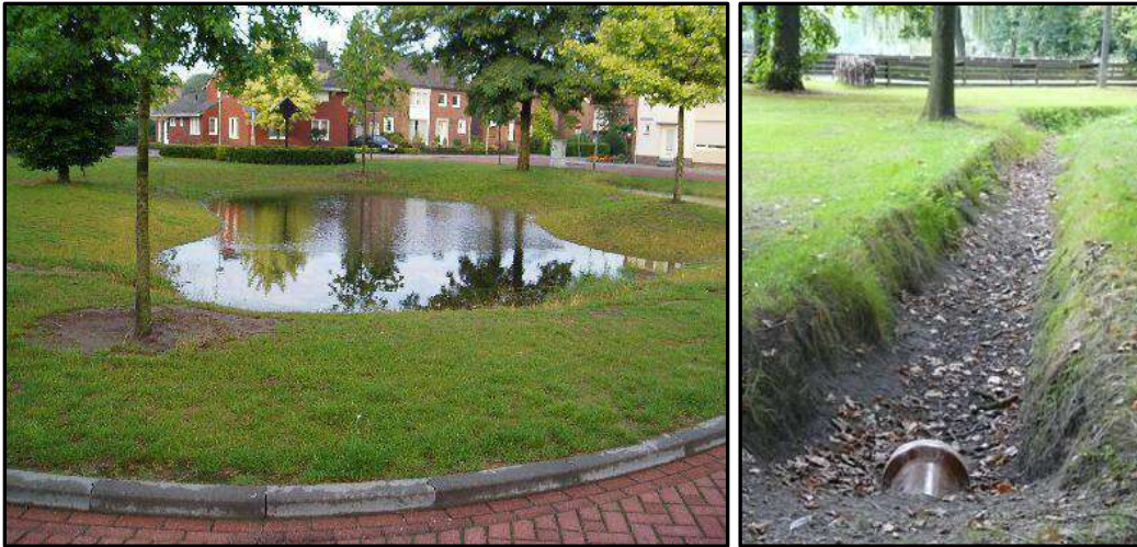
Figuur 78: Voorbeeld wadi en infiltratiegracht (Waterbewust bouwen, 2020)
